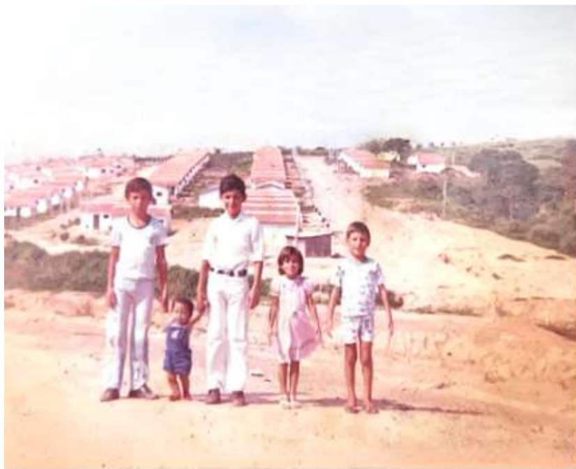
Gilmar Cruz, Adriano de Souza, Jaime, Vanilda e Valdir Cruz 1981 - ao fundo as "casas próprias" - Três Irmãos - em construção Hoje: ao fundo, Praças, escolas e Unidade de Saúde
